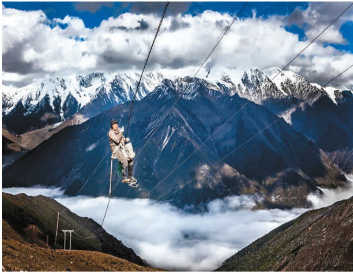
2017年10月24日，四川康定贡嘎山子梅垭口，电信工人在铺设宽带网络到雪山下的子梅村。图为“一个也不能少——全国脱贫攻坚摄影展”展出作品。 胡南丹摄
